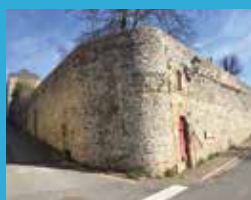
Mur de soutènement, avant...
